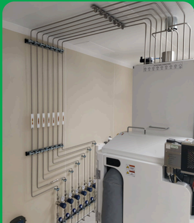
Hook-up équipement Gaz UHP Ra < 0.2\mu m
