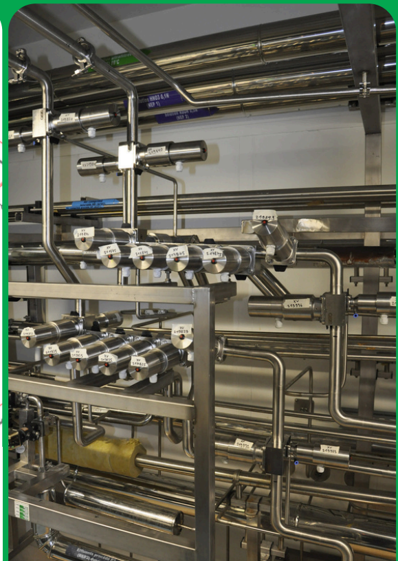
Lignes de transfert Blocs vannes à membrane
